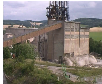
Silo in Weimar, Germany Videos by courtesy of Dr.-Ing. Rainer Melzer Planungsbüro für Abbruchsprengen
